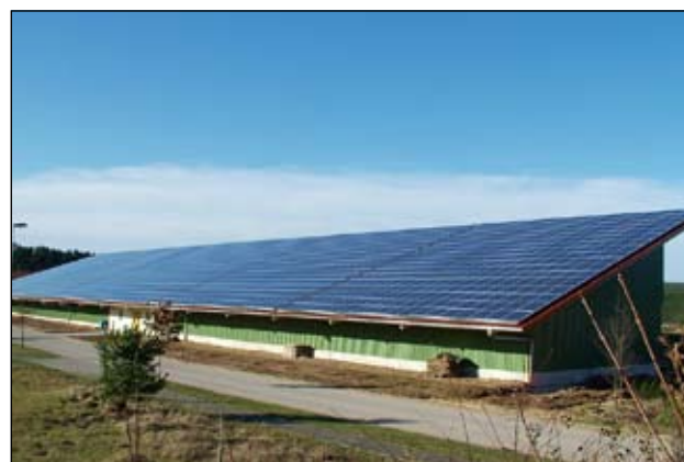
Fotonaponska elektrana u Njemačkoj, maks. snaga: 300 kW
